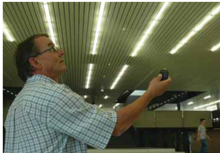
Stolz zeigt der engagierte Gebäudetechniker Bachmann den Handsender, mit welchem externe Aussteller endlich ohne Suchen von Tastern jederzeit die Beleuchtung bedienen können.
